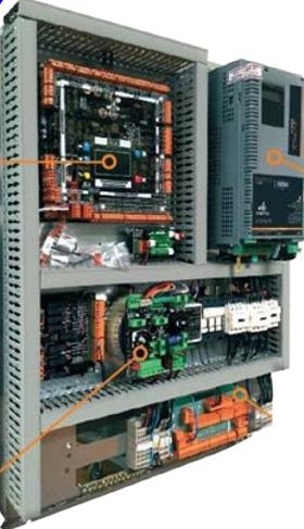
**Armoire de manœuvre + pré-cablage**
